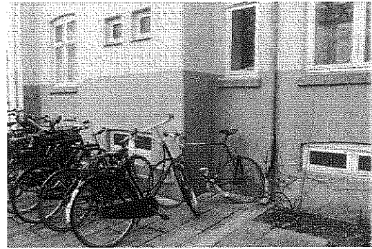
Underfacade mod gård, istandsat, fin sokkel
